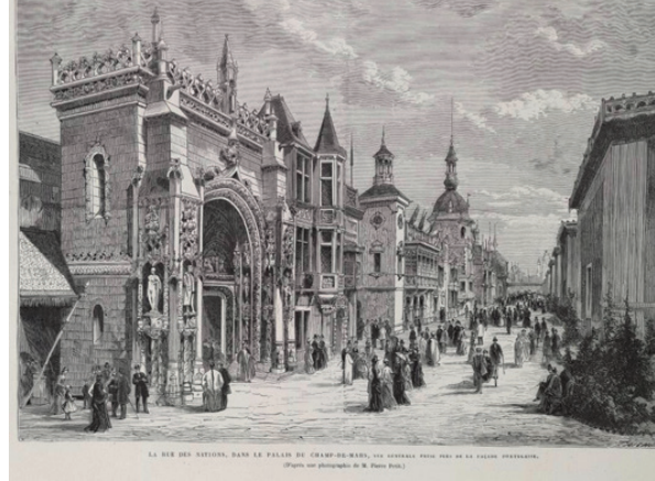
13. vue de la rue des Nations, dans le palais du Champs de Mars, prise près de la façade portugaise
