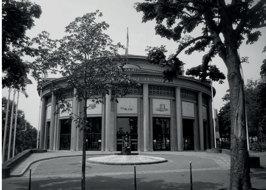
17. vue extérieure du Musée des Travaux Publics par Auguste Perret de 1937 à 1946
