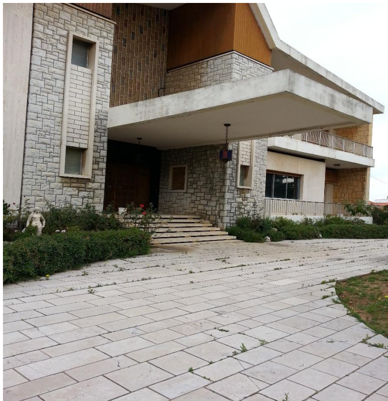
Figure 4-1 : Vue extérieure de l'entrée de la villa.
