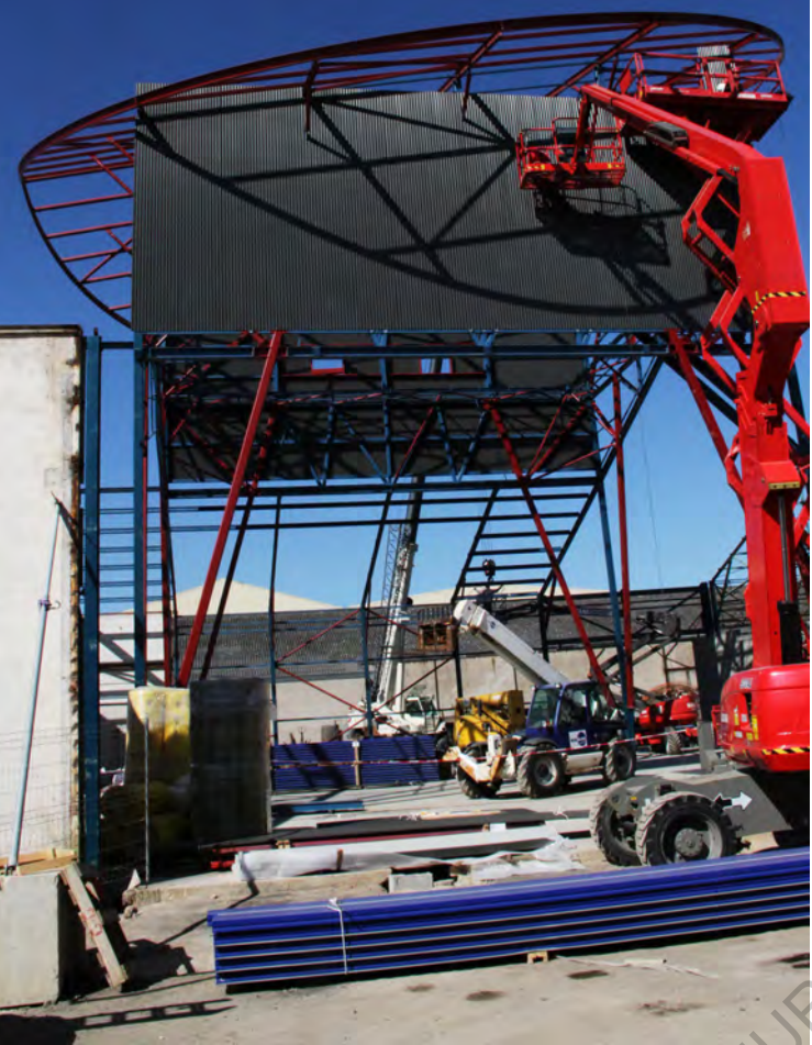
4. Pose de l'isolation de la toiture par les ouvriers de la SMAC.
