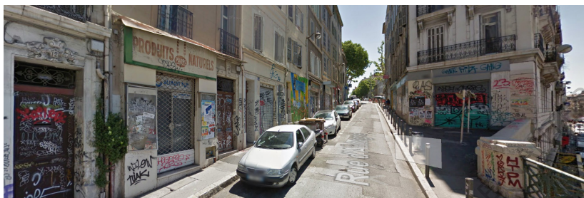
Rue d'Aubagne dans le centre de Marseille
