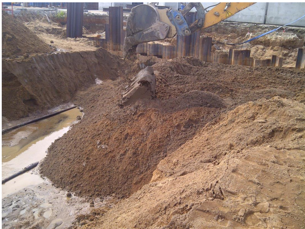
Figure 67 - Vue du remblai des tirants après leur mise en œuvre
