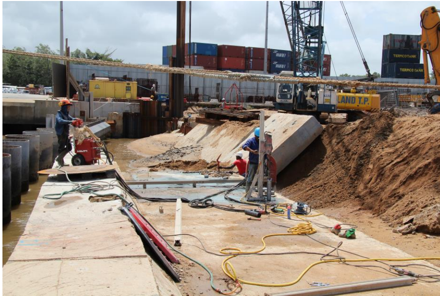
Figure 53 - Vue du sciage de la 2ieme phase
