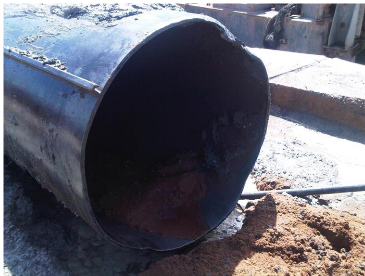
Figure 17 - Vue d'un pied de tube après vibrofonçage
