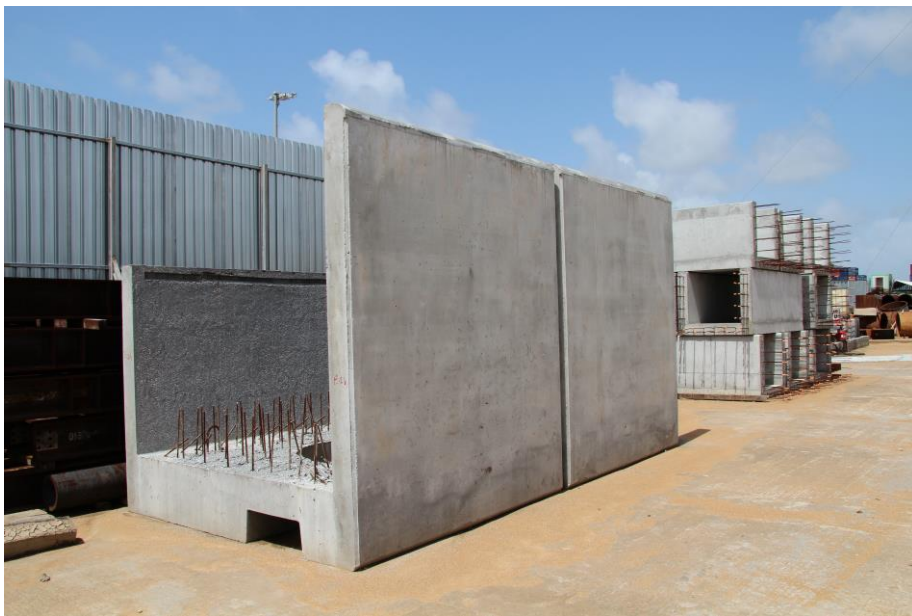
Figure 49 – Vue des pièces préfabriquées après décoffrage
