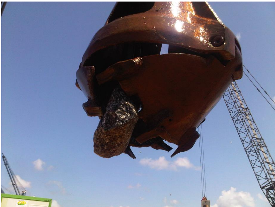
Figure 60 - Nettoyage du fond des pieux a la benoto
