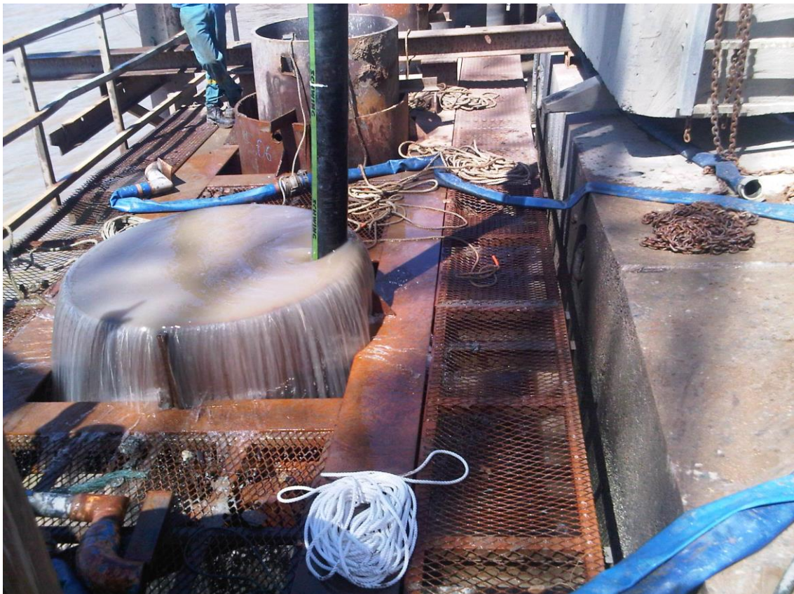
Figure 62 - Coulage du béton à la pompe sous l'eau.
