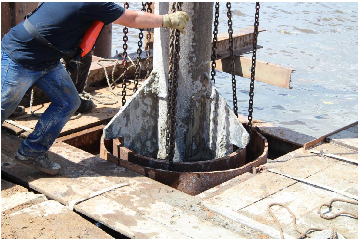
Figure 64 - Vue des dispositifs de centrage et de la mise en place de la racine
