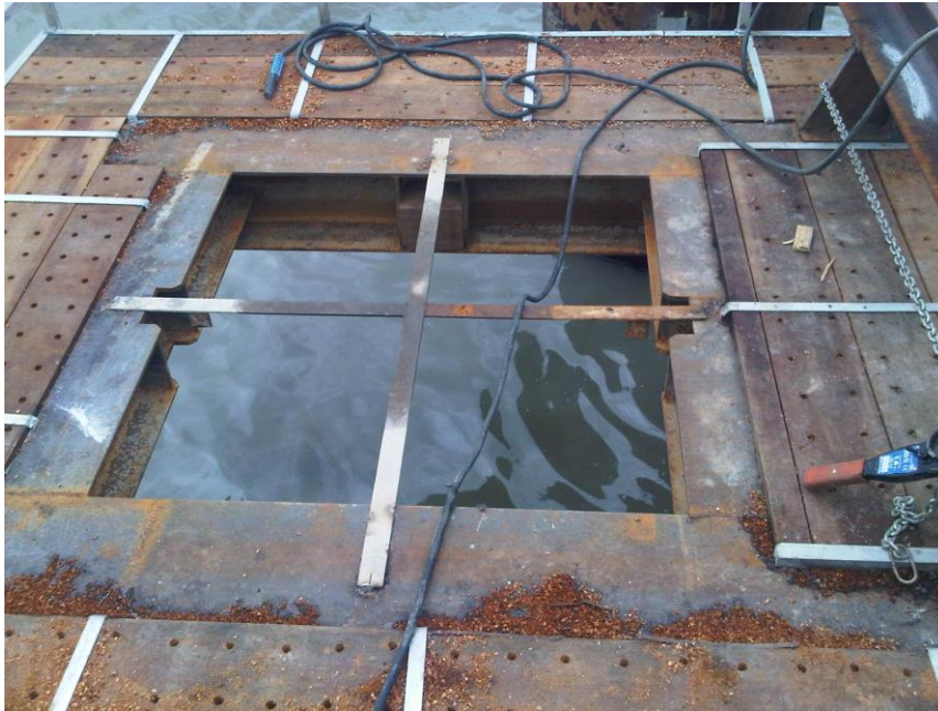
Figure 56 - Dispositif de centrage pour contrôle de la position du guide par les géomètres
