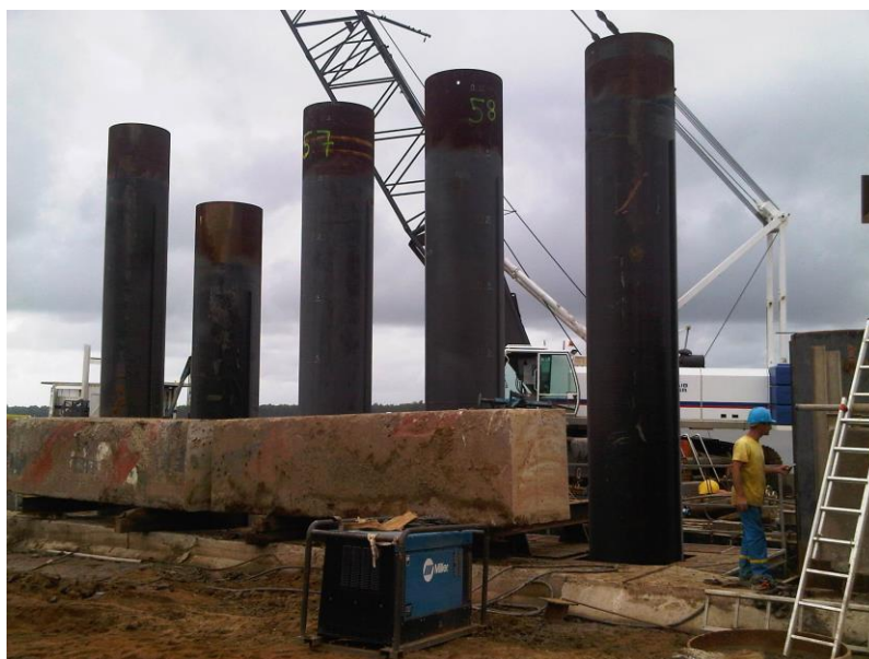
Figure 58 - Vue des pieux après mise en fiche
