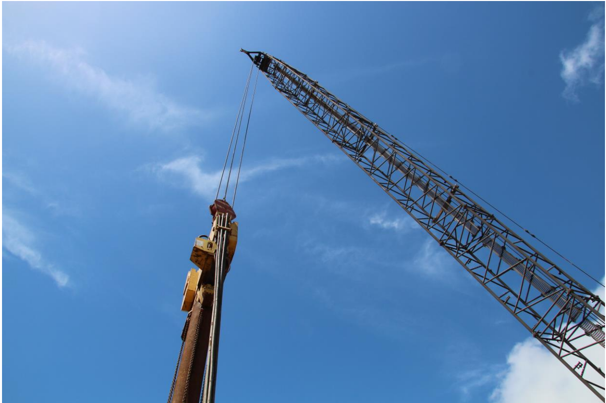
Figure 65 - Vue du vibrofonneur et tête de pieu de 406
