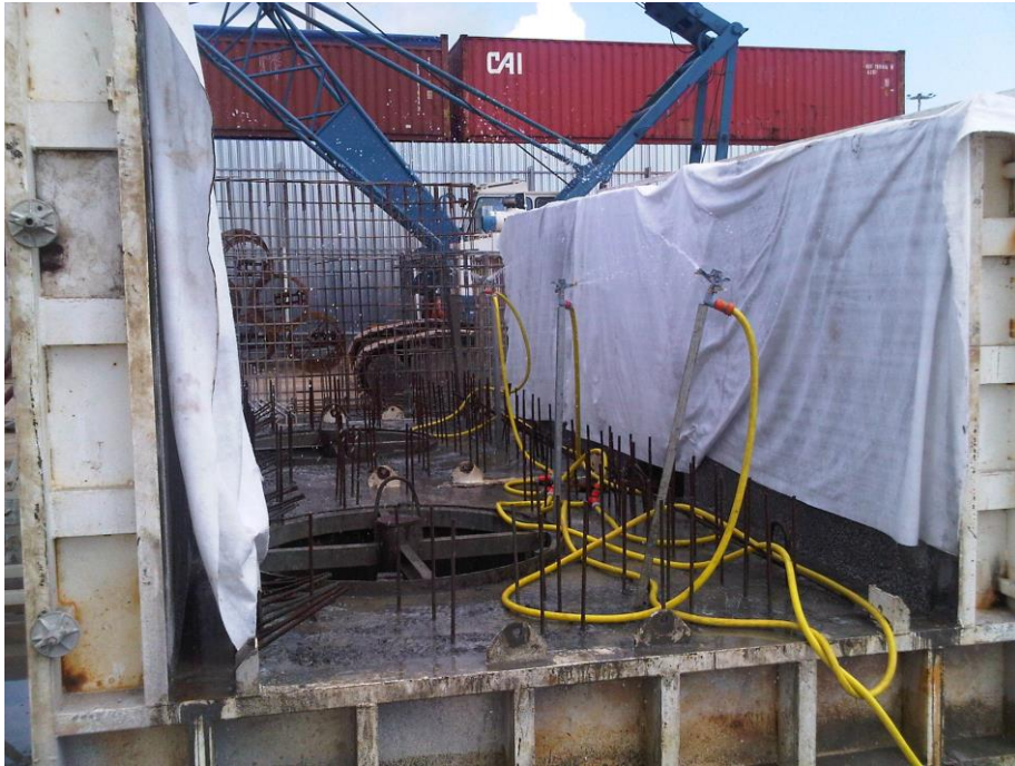
Figure 48 – Vue des pièces coulées dans le coffrage
