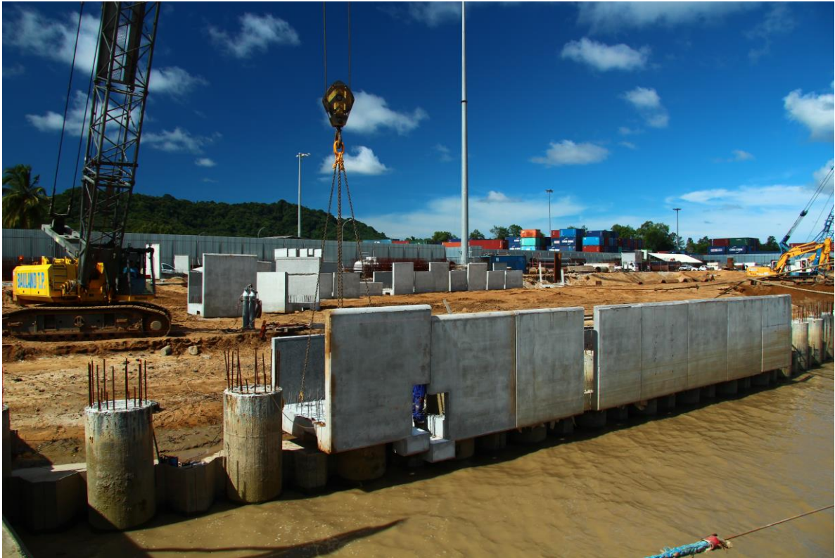
Figure 69 – Vue de la mise en place du premier linéaire de poutre
