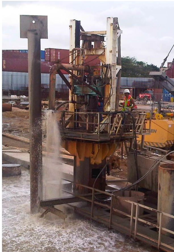
Figure 25 – Vue du cluster en fonctionnement
