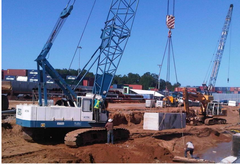
Figure 51 - Vue de la manutention des blocs (première phase)
