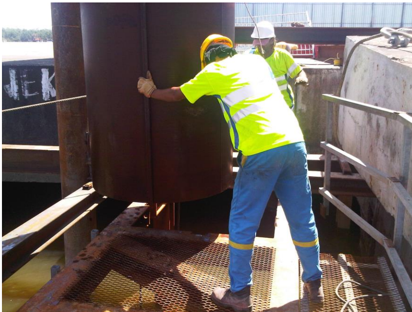
Figure 57 - Mise en fiche des tubes dans le guide de battage
