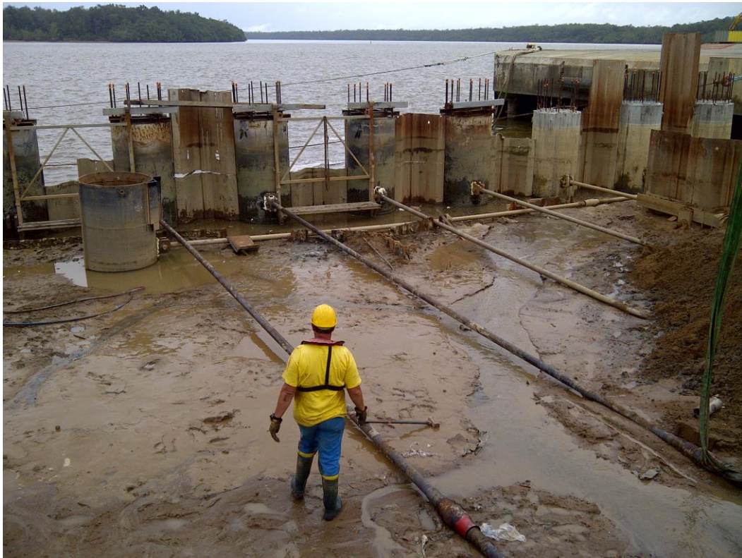
Figure 66 - Vue de la zone de pose des tirants à marée basse
