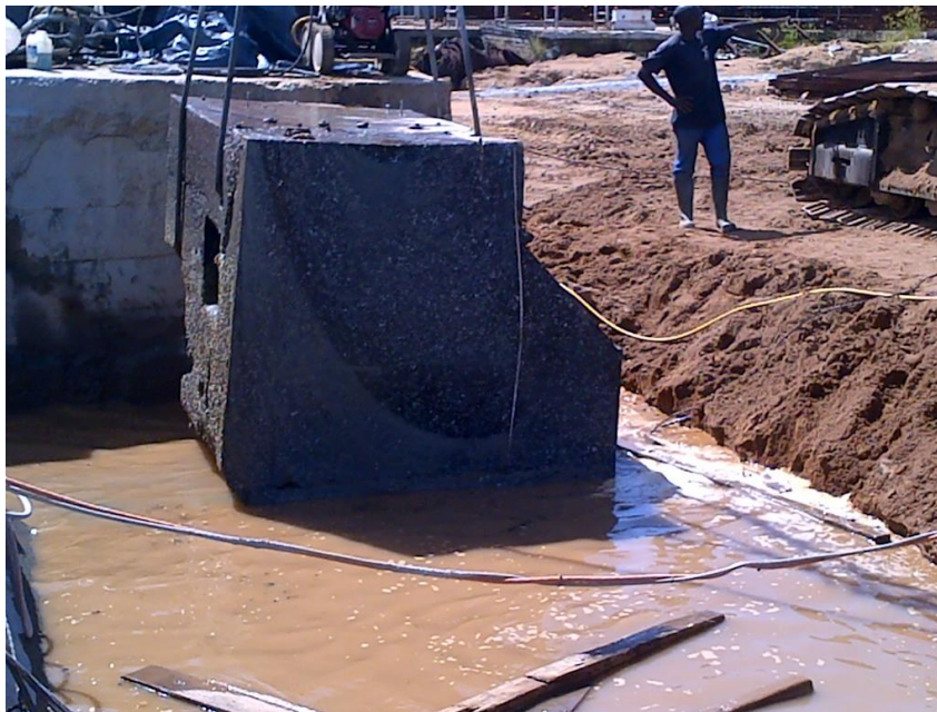
Figure 52 - Vue de la manutention des blocs de la 2ieme phase
