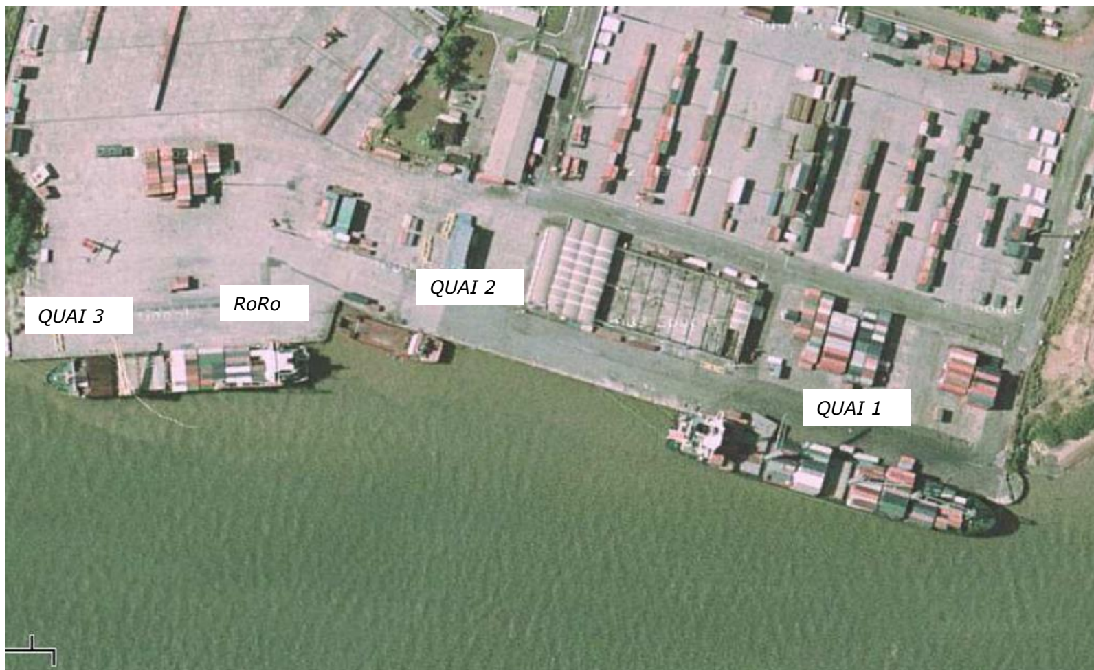
Figure 2 - Vue aérienne du port
