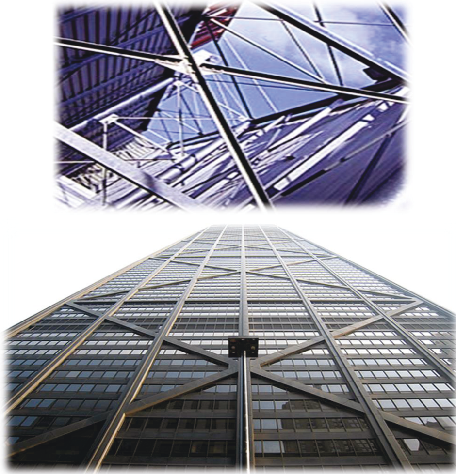
Fig. 40: Les lieux d'utilisation des contreventements
