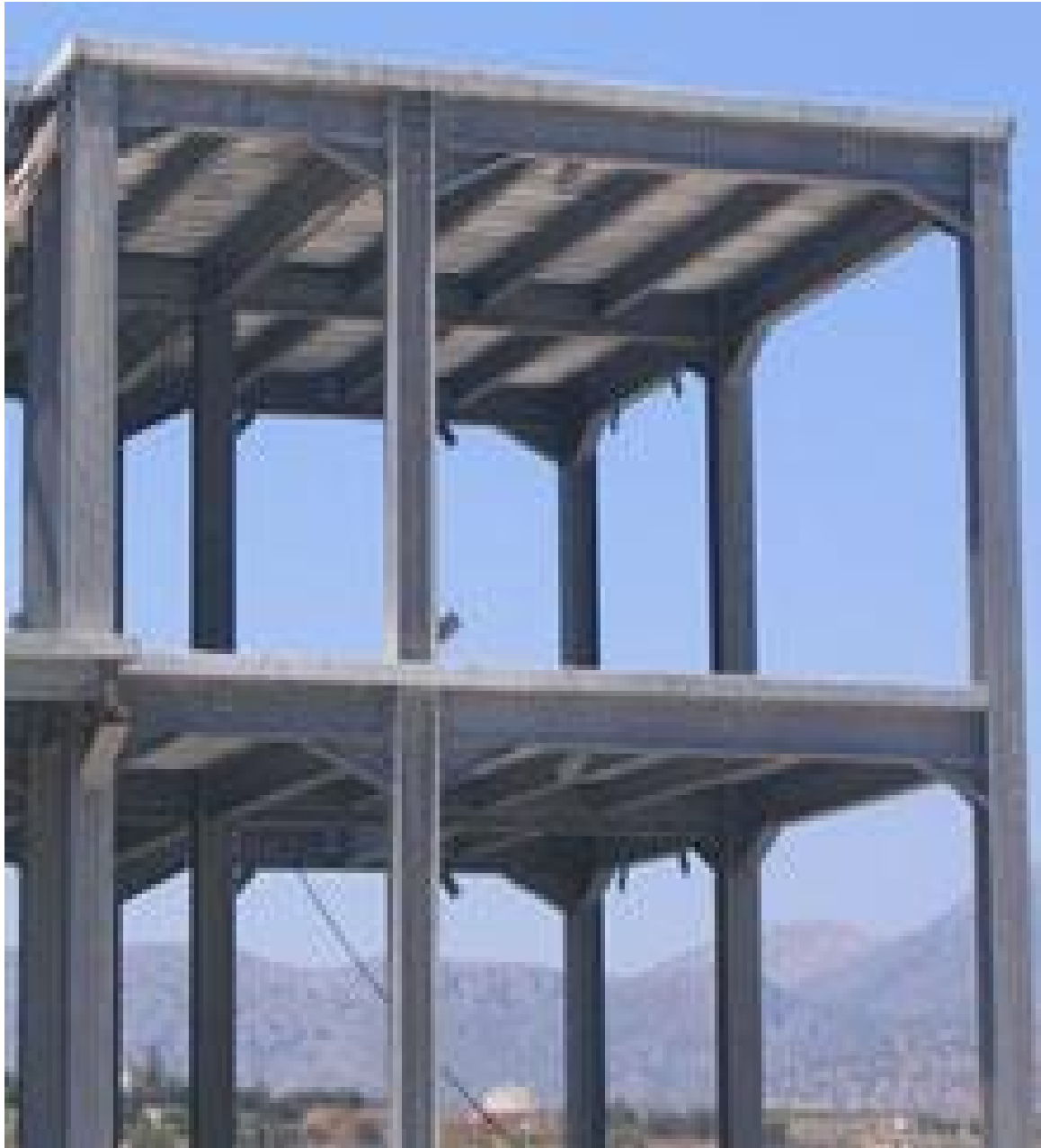
Fig. 1: Vue général d'un bâtiment métallique
