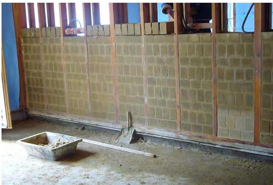
Figure 18. Ci-dessus — Remplissage de l'ossature avec les BTC ; l'atelier belenfant daubas ; 2007
