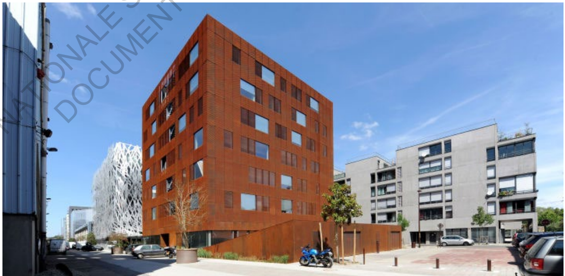
Île Rouge : l'intégration de cette opération dans le site se fait via la peau d'acier corten, image du travail industriel du métal, et par l'insularité du bâtiment, entouré d'un léger décaissement planté. Les deux volumes, un bas pour les services et un haut pour les bureaux, permet d'organiser une place entre l'île rouge et les halles Alstom, rendant le mail du Front populaire plus accueillant et plus visible depuis la rue.
