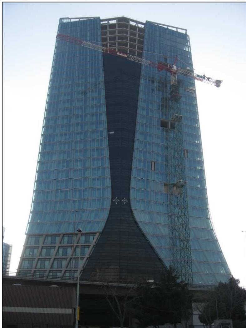
Figure 77 - Démontage de la grue G1
