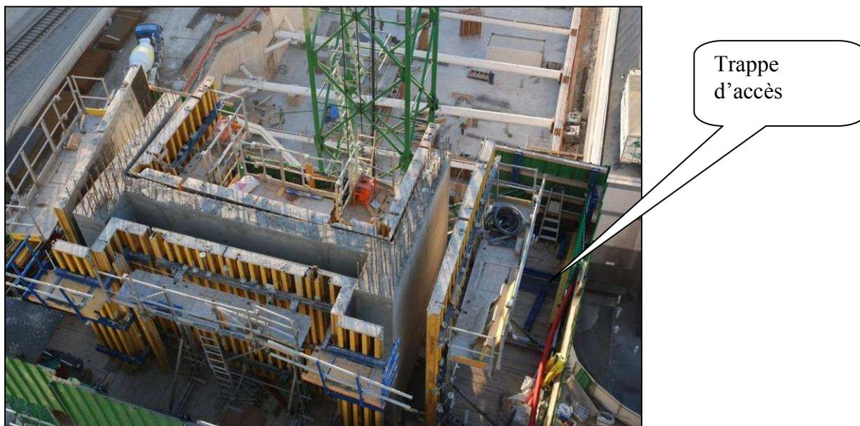
Figure 55 - Outil glissant après bétonnage
