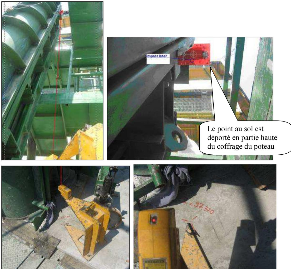
Figure 65 - Positionnement des faisceaux lasers
