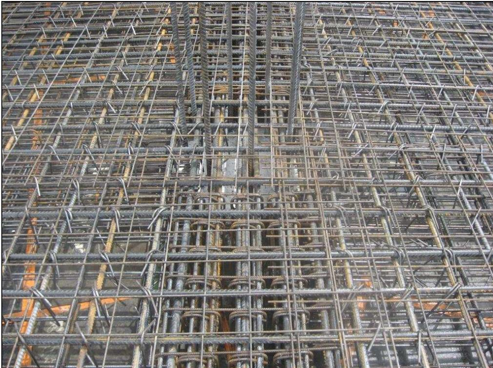
Figure 39 - Ferrailage de plancher
