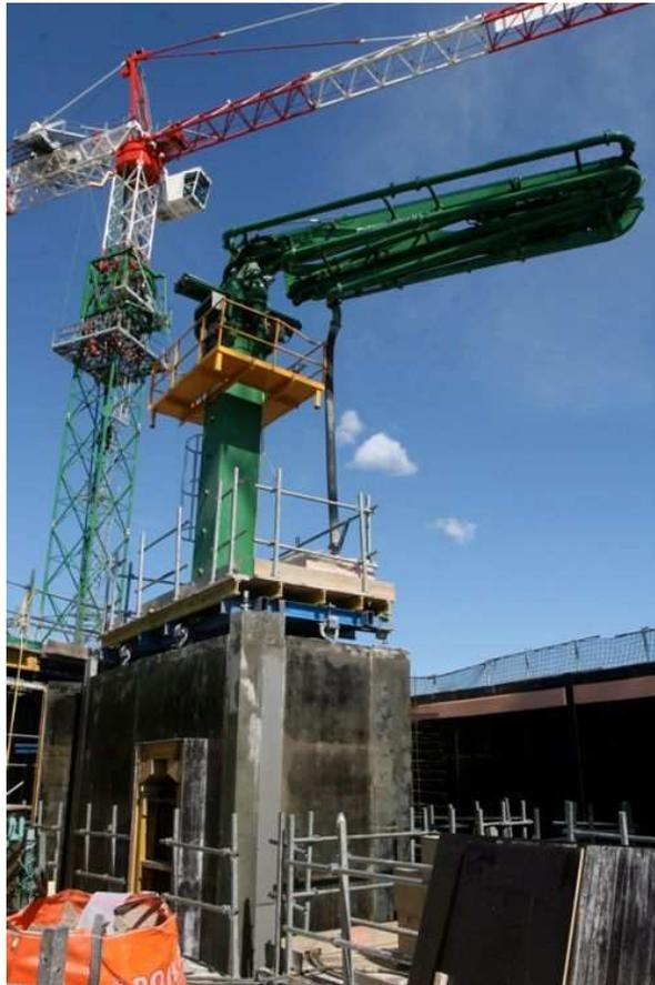
Figure 49 - Mât de bétonnage
