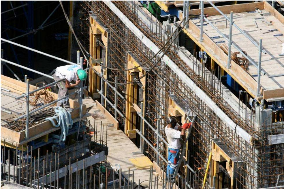
Figure 48 - Mise en œuvre des voiles du noyau
