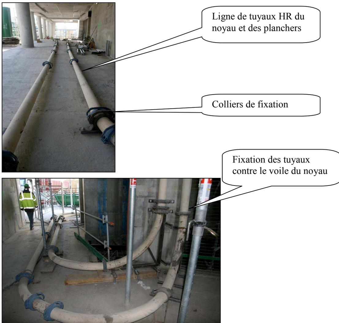
Figure 88 - Colonne de bétonnage
