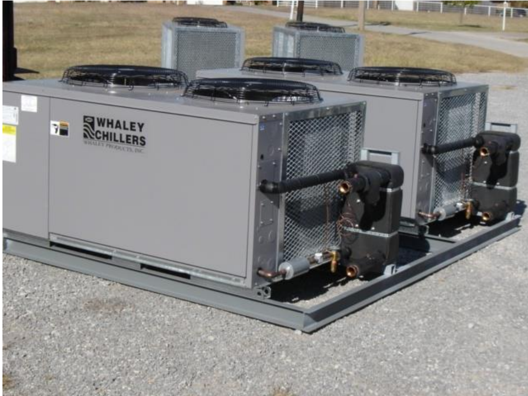
Figure 10 : Le groupe refroidisseur liquide
