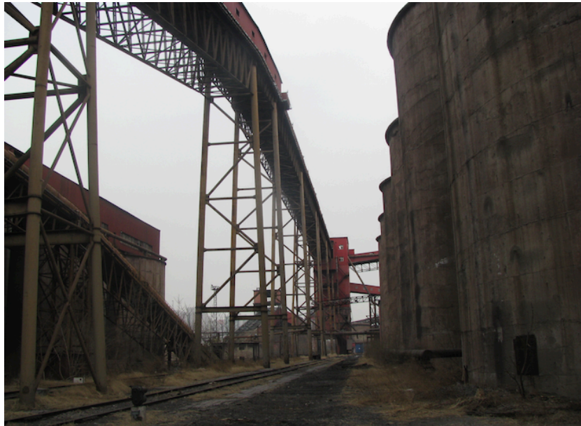
Image 19 : les dix silos en 2013 Photographie issue de l'Entreprise du développement culturel de Shougang
