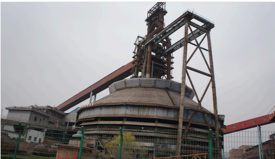
Image 12 : le troisième haut-fourneau de Shougang Photographie de ZHANG Yunxi, 29-03-2015
