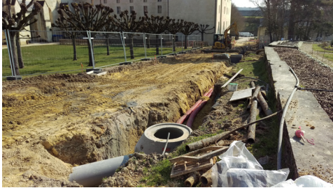
Fig 58: Chemin le long des tilleuls en travaux, crédit photo: Urbaterra
