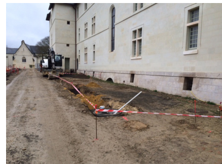
Fig 61: Chemin en travaux de la partie basse, crédit photo: Urbaterra
