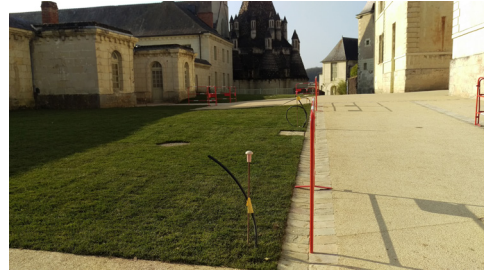
Fig 59: Entrée de l'Abbaye en cours de chantier, crédit photo: Urbaterra
