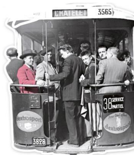
Figure 31 – Le TN4 H de la ligne 38
