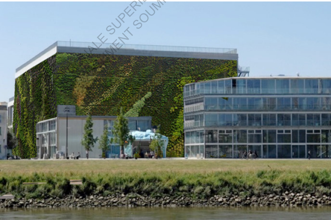
Fig. 3.5 : Collage de façades végétalisées sur l'école d'architecture
