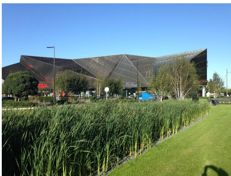
Figure 24 : centre commercial Enox (crédit photo : Atelier Paul Arène)
