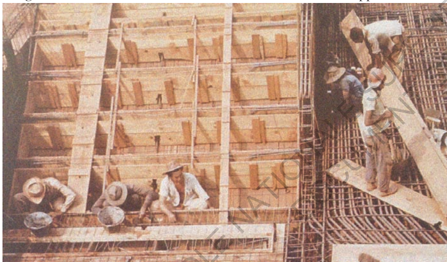
Chantier de Brasilia, des constructions consommatrices en bois à usage unique.
