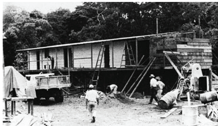
Baraquement ouvrier de fortune au début du chantier
