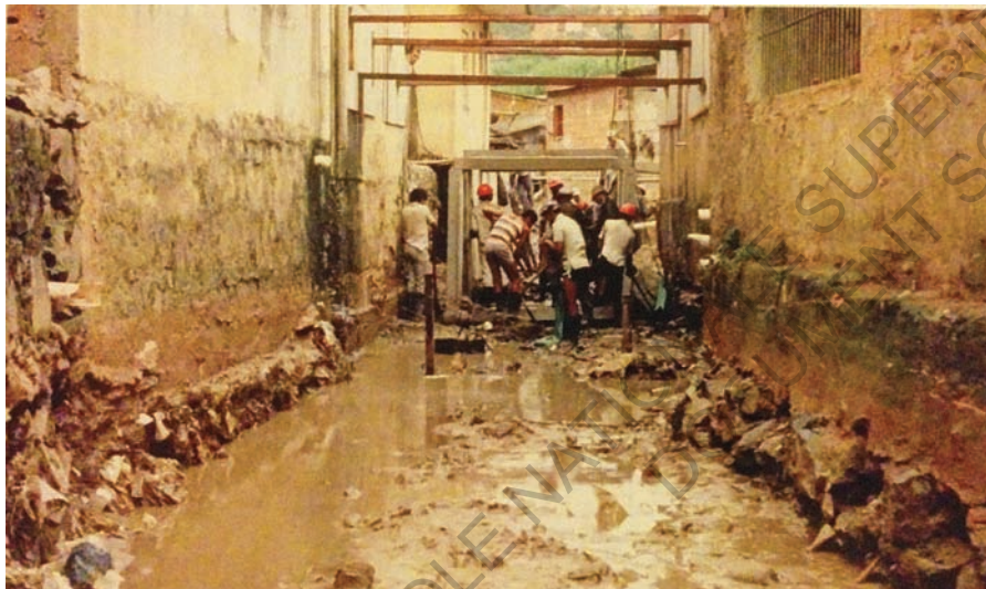
Les habitants creusent et installent le canal de drainage.
