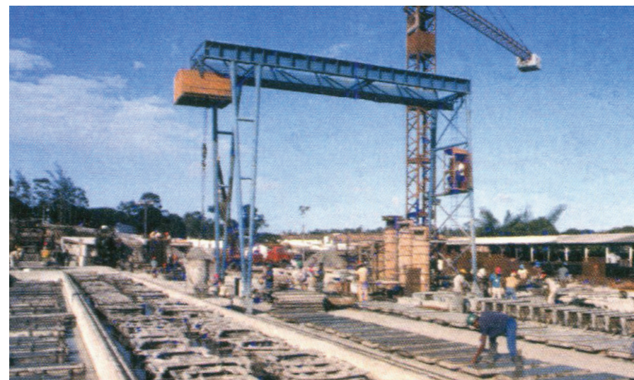
La première grande fabrique de Lelé, RENURB.
