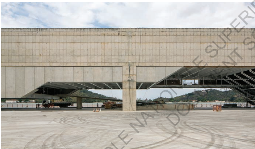
Cais das artes - Paulo Mendes da Rocha & Metro - en construction depuis 2007, Vitoria, ES, Brésil.
