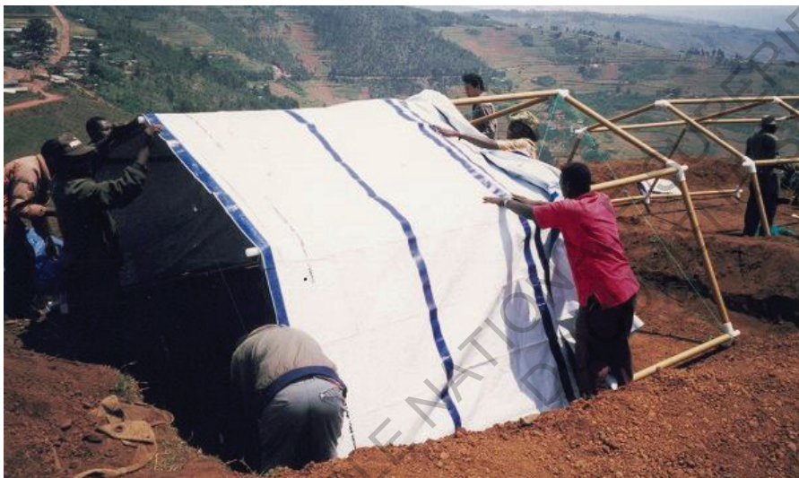
Montage des abris simple pour le Rwanda 1994.
