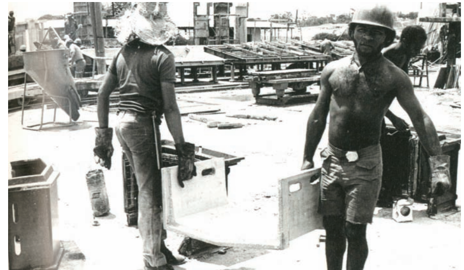
Transport de modules légers aisément manipulable par l'Homme.
