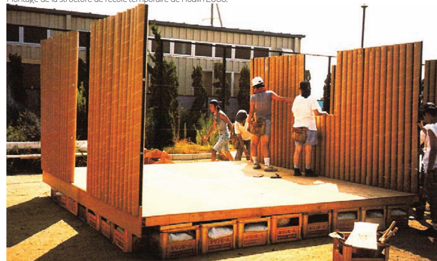
Montage des abris temporaire après le tremblement de terre de Kobe 1995.
