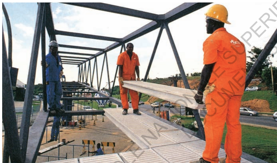
Montage manuel de pièces simples, légères et changeable simplement en cas d'usure. Ecole transitoire Abadiânia (au dessus), Passerelles de Salvador (en dessous).
