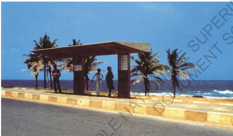
Arrêt de bus en préfabriqué dessiné et réalisé par RENURB.
