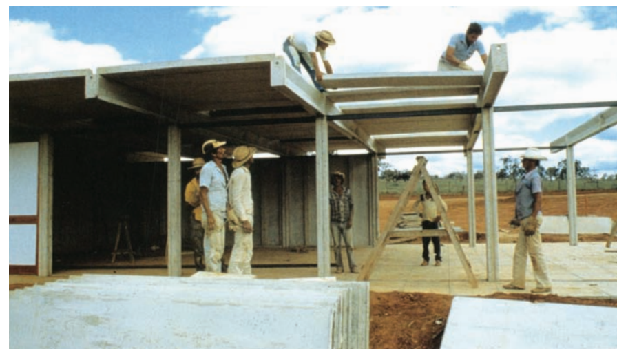
Montage d'une des écoles transitoire d'Abadiânia.
