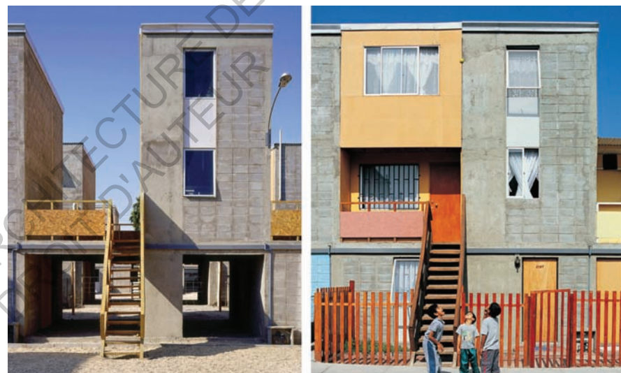
Quinta Monroy, avant et après l'aménagement par leurs utilisateurs.
