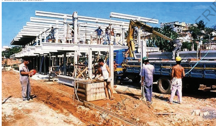
Montage d'une des écoles de la FAEC.
