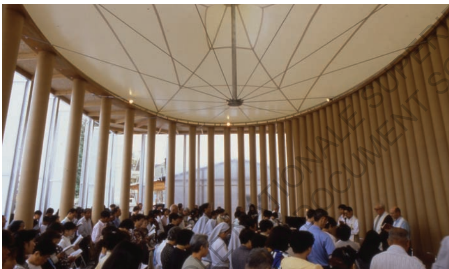
Eglise temporaire après le tremblement de terre de Kobe, aujourd'hui démontée et réinstallée à Taiwan.
