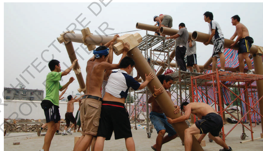
Montage de la structure de l'école temporaire de Hualin 2008.
