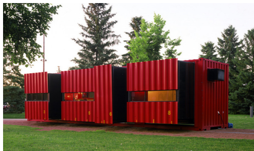
Fig.21: unité lot-ek, logement mobile.
