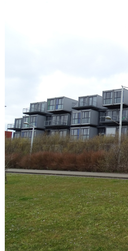
Fig.98: vue de la résidence depuis le canal.
