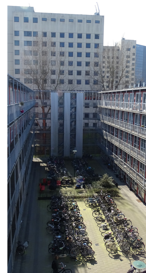
Fig.83: cour au sein d'un bloc: parking à vélos.
