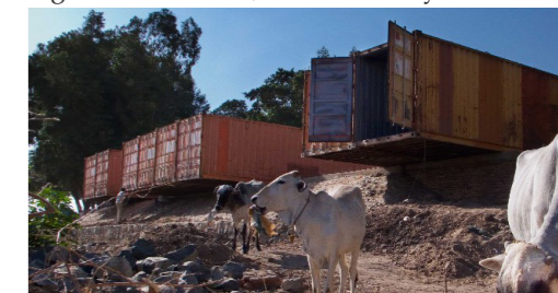
Fig.34: Début du chantier, TAM Associati.
