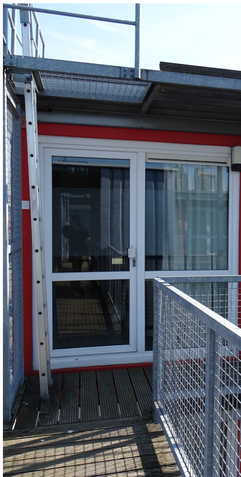
Fig.84: porte d'entrée d'un logement.
