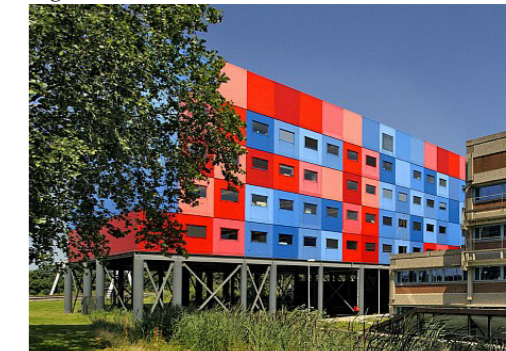
Fig.38: Extérieur du bâtiment provisoire.
