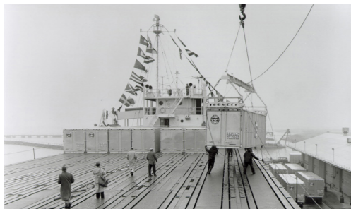
Fig.11: chargement sur le pont des conteneurs.
