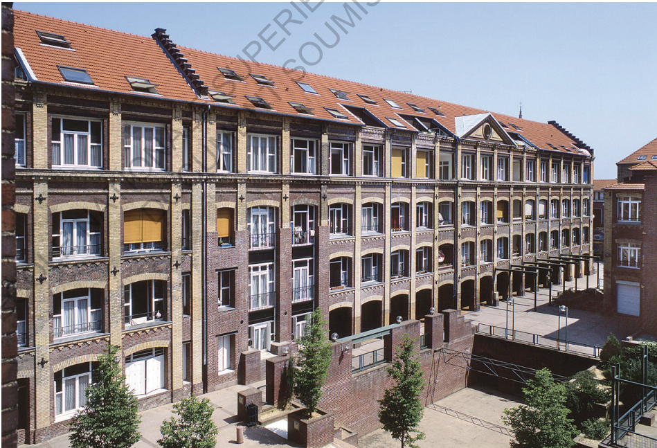
Reconversion de l'usine de draps Blin et Blin à Elbeuf par l'agence Reichen et Robert en 1983. 151 logements sociaux ont été créés. Source : Yvon Miossec
