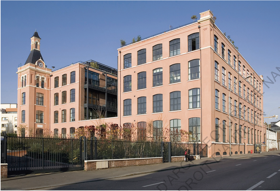
À Rouen, en 2001, la filature Berger et cie échappe à la destruction et est reconverte en lofts. L'édifice est percé en sa partie centrale pour permettre à tous les logements de bénéficier de lumière naturelle. Source : Denis Couchaux
