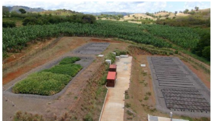
Figure 2 : STEP de Mansarde Rancée au Robert – photo aérienne
