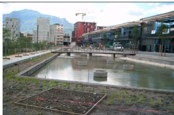
Bassin servant de récupération des eaux de pluie, d'agrément paysager, et de stockage d'eau d'arrosage à la caserne de Bonne à Grenoble
