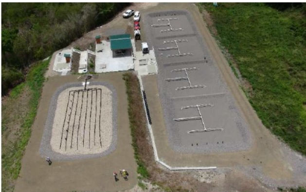
Figure 1 : STEP de Taupinière au Diamant - 1er étage – photo aérienne
