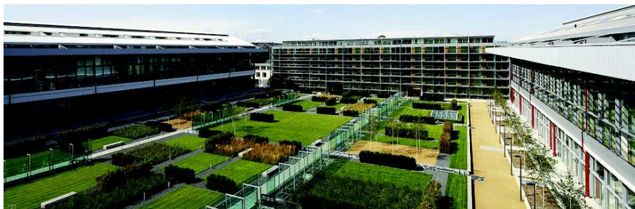
Vue intérieure de Highbury Square
