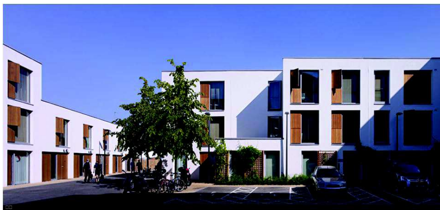
Logements sociaux de l'opération
