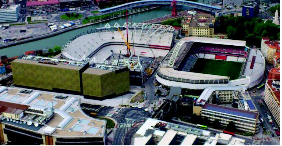
Le stade San Mamès de 1913 et son successeur durant le chantier
