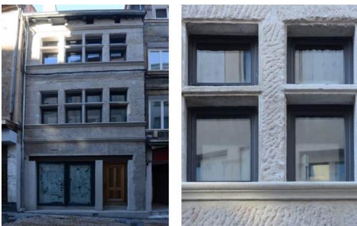
Figure 5 : Exemple bâti de l'époque renaissance. Source : AVAP Centre - Nord
