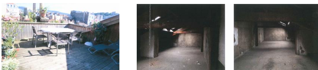
Figure 34 : Photo d'une terrasse réalisée (gauche) ; photo combles avant travaux (droit)
