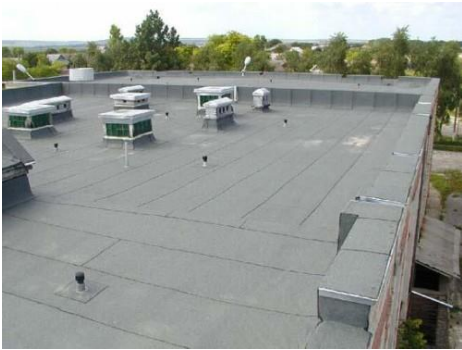
Figures 24 : Toit plat utilisé comme un étage technique. Source : vsyaizolyatsiya.ru ; krovel.net.ua (rus).
