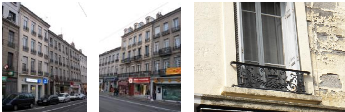
Figure 7 : Exemple constructions typiques stéphanois. Source : AVAP Centre - Nord, archive EPASE
