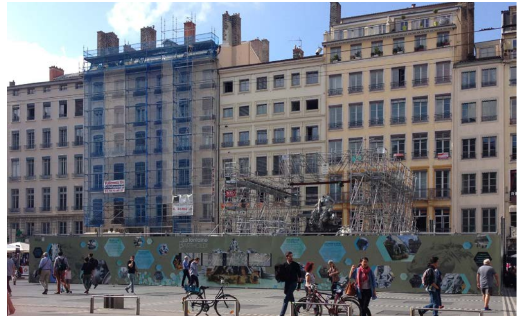
L'emprise des travaux de rénovation de la fontaine
