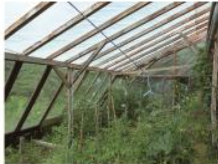
Serre en verre adossée à un mur
