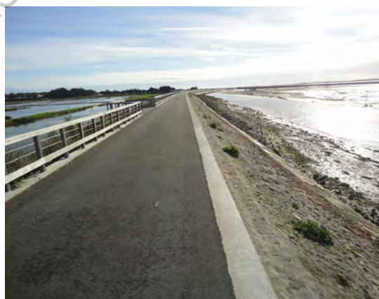
Digues Jacobsen Noirmoutier 1
