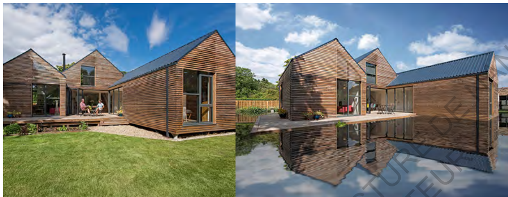
Maison sur pilotis, dans l'Oxfordshire 1
