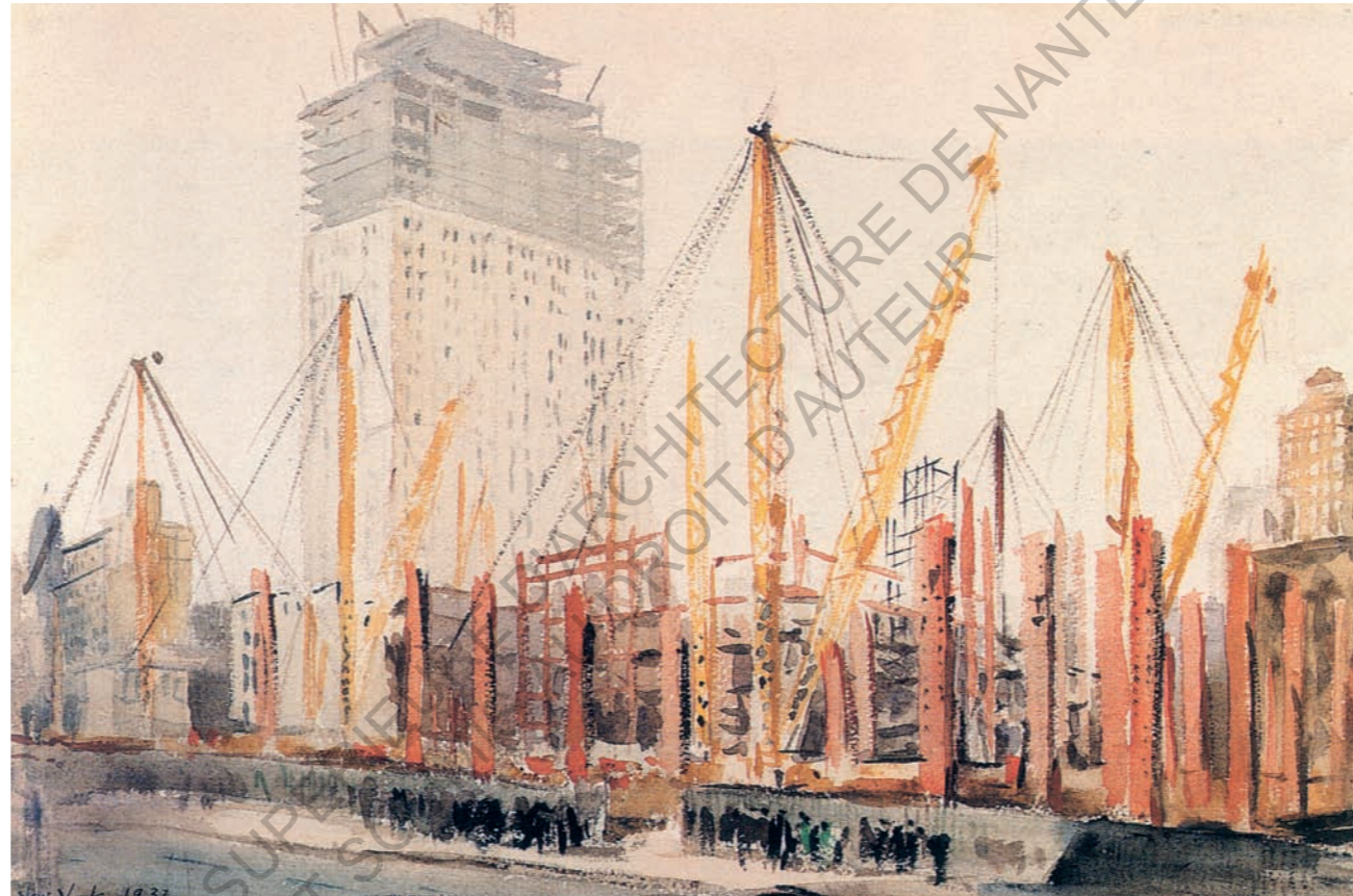
7. R. CAMELOT, Construction de Radio-City à New York, 1932.
