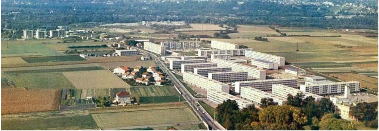
Figure 2: La cité de la Grappinière dans les années 60 – Photographie de la Mairie de Vaulx-en-Velin
