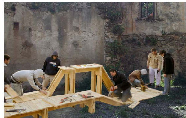
Chantier participatif, construction de prototypes à l'échelle 1 (©collectif Etc).
