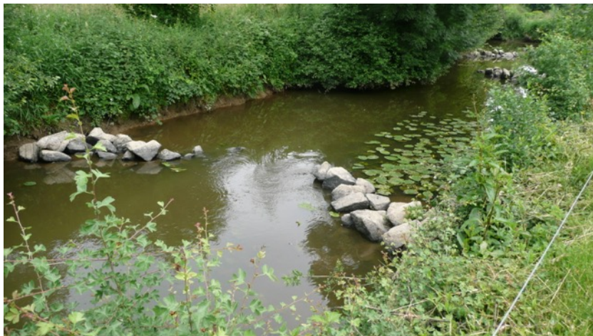
Figure 7 : Site d'étude 2 - Mise en place de blocs dans le cours d'eau (Source auteur)
