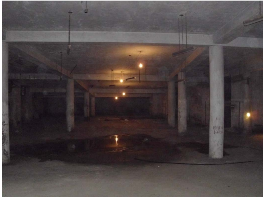
Figure 3 : Le garage en B3 avant la restauration (3ème étage sous-sol)
