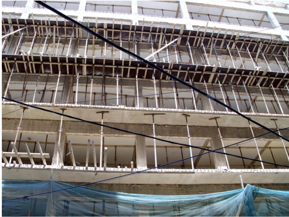
Figure 1: La façade de l'hôtel MAK Palace au début de la restauration
