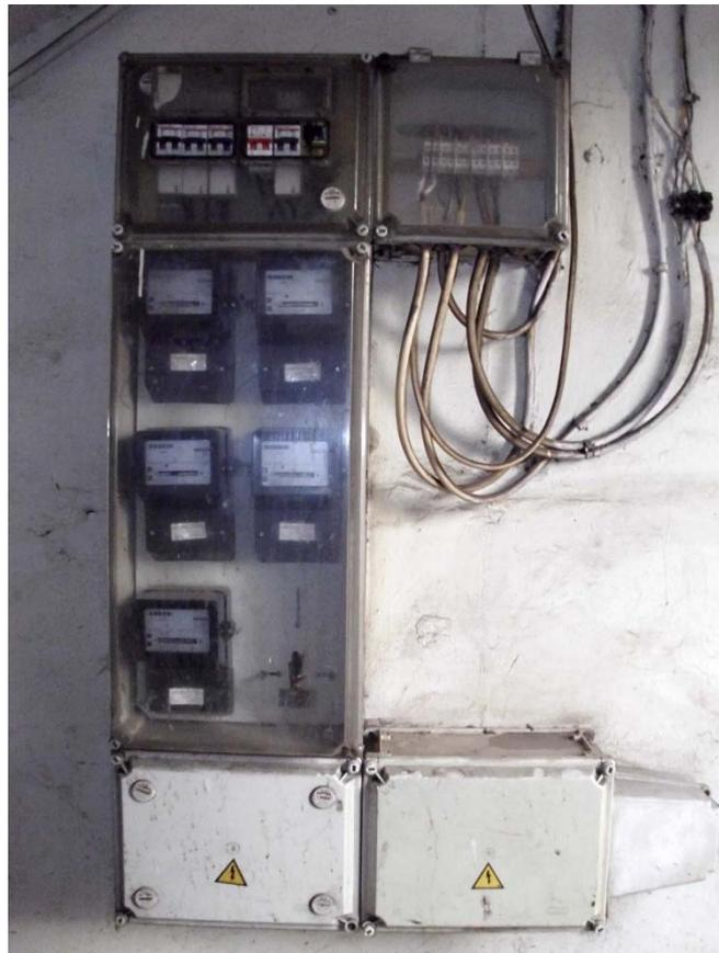
*Figure 32 : Compteur d'énergie kWh*
