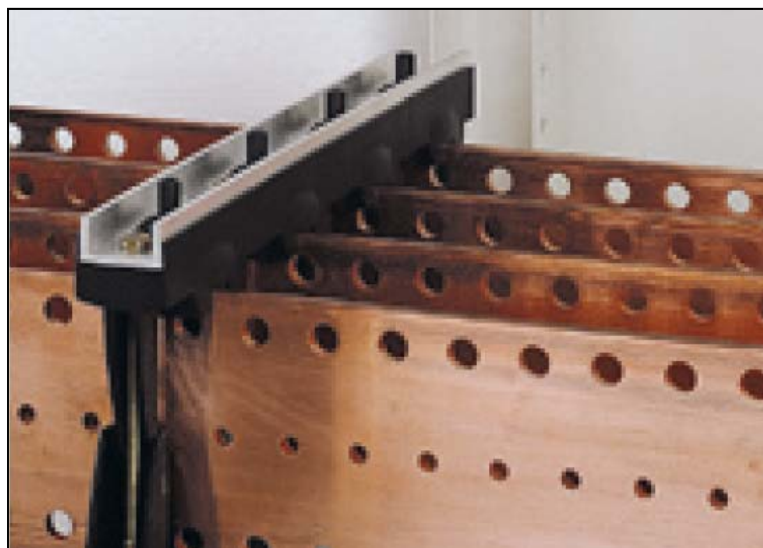
Figure 28 : Distance maximale permmissible entre 2 supports [9]
