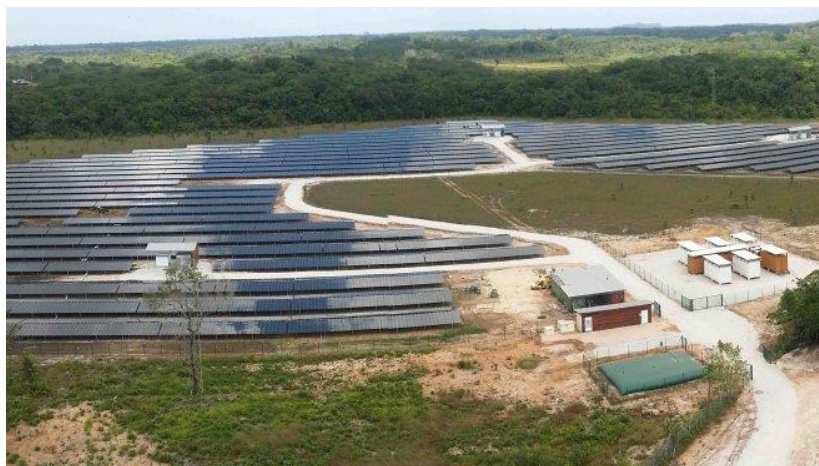
Figure 14 : Vue aérienne de la centrale solaire photovoltaïque de Toucan, en Guyane. Source : EDF EN France
