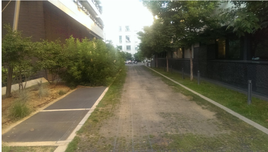
Figure 18 : Photographie représentant des jeunes arbres et du revêtement au sol perméable favorisant l'infiltration des eaux pluviales Source : J. NAEGELEN, 2016
