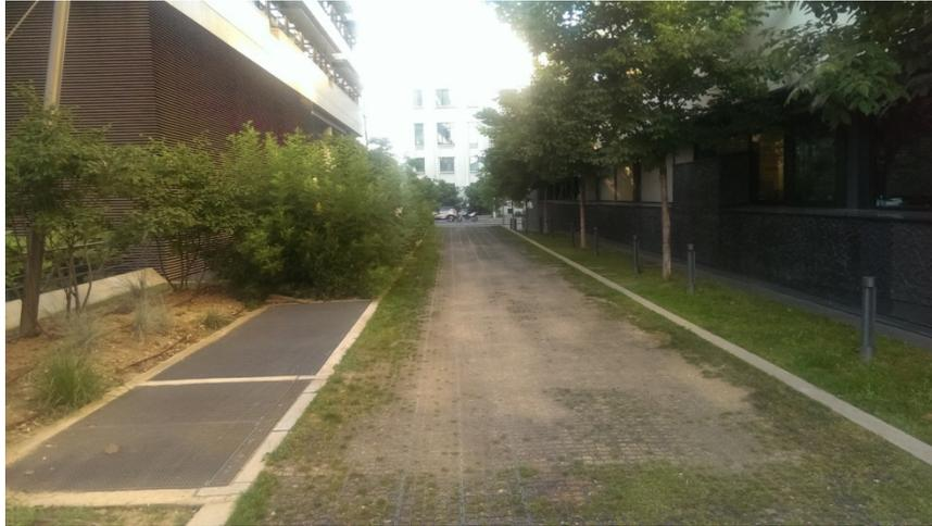
Figure 18 : Photographie représentant des jeunes arbres et du revêtement au sol perméable favorisant l'infiltration des eaux pluviales
