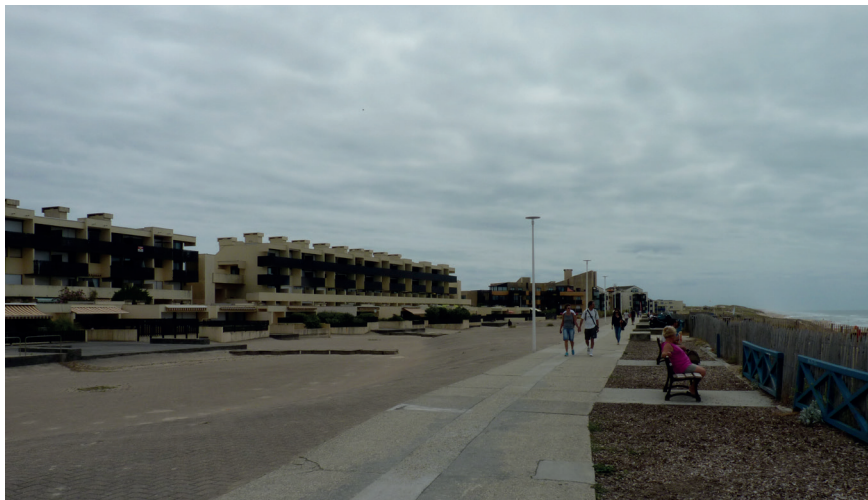
Fig. 5 : résidence L'Océanide et le front de mer de Lacanau. Source : Elise Seremet, juillet 2016.
