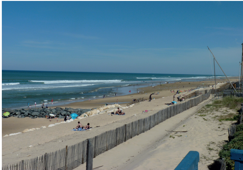
Fig. 25 : enrochement sur la plage en milieu urbain à Lacanau. Source : Elise Seremet, mai 2016.
