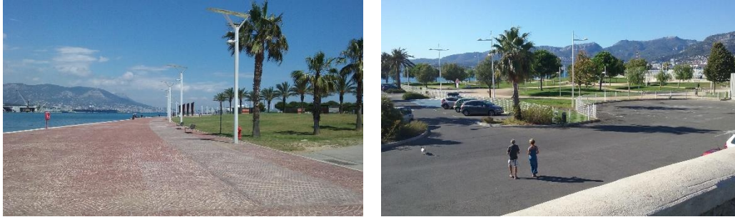
Figure 34 : Le parc de la Navale et le parc de la Tour Royale, ouverts sur la mer (clichés : M. Le Fischer, 2016)
