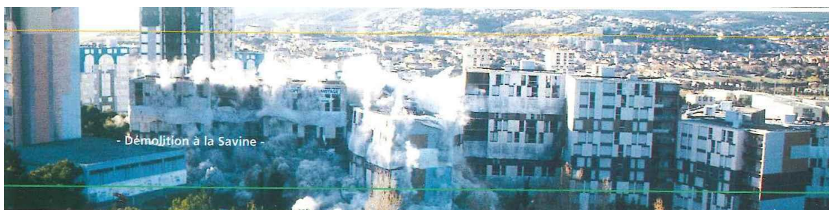
Photographie 5 : Démolition à la Savigne (Logirem, 1995)
