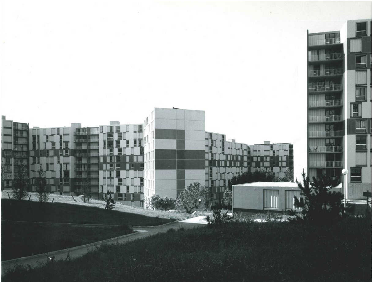
Photographie 1 : Bâtiments de la Savine à la fin des années 1980 (archives Logirem)
