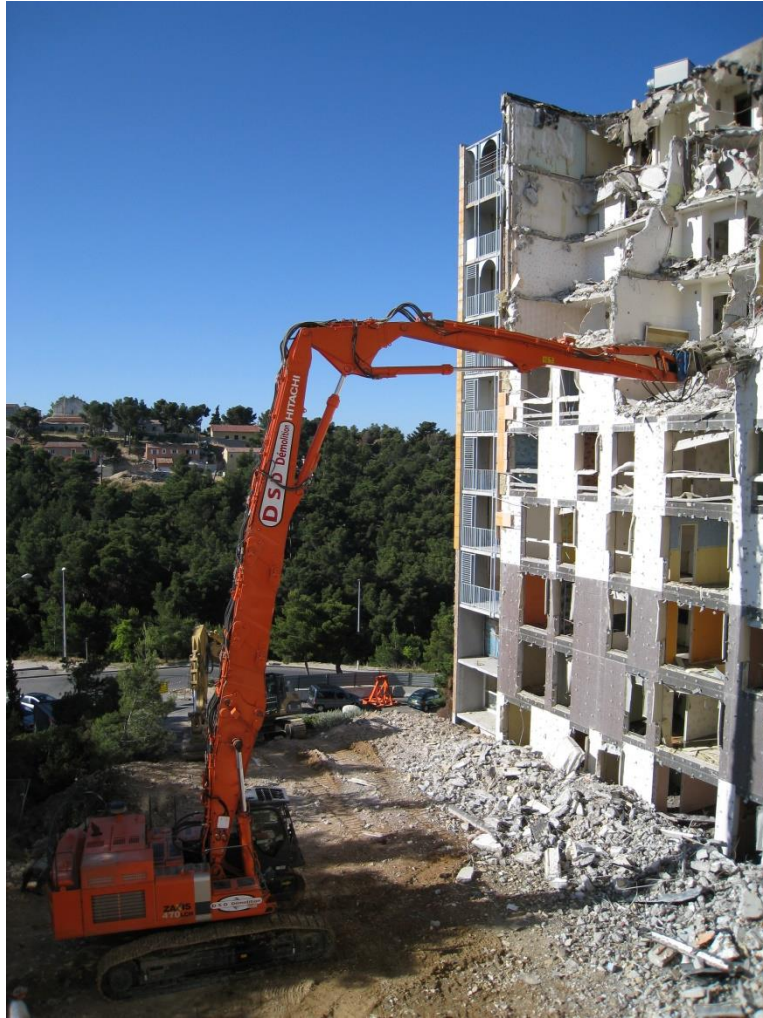
Photographie 7 : La démolition du bâtiment A par la grignoteuse (Logirem, 2010)
