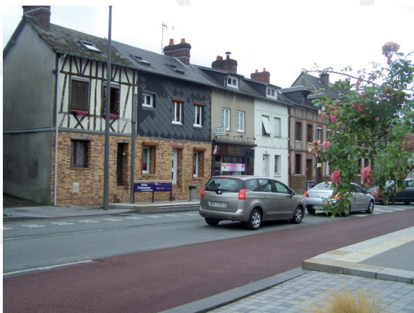
Figure 9 : Le site propre en enrobé rouge du Teor de Rouen (Pierre DUHAMEL)
