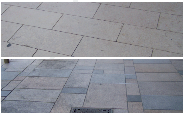
Figure 12 - Exemples de revêtements sur voies douces. En haut à Rouen, en bas à Nantes (Pierre DUHAMEL)
