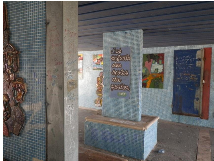
Fig n° 59: Le porche du bâtiment M, un espace occupé par les jeunes
