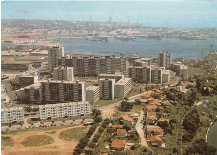
Fig n°35 : Des petites maisons dans l'ombre des GE
