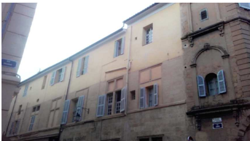
Figure 32) Immeuble bourgeois aux baies anormalement exigües, rue Esparriat, Aix en Provence février 2016 Les logements indignes en raison d'une surface vitrée trop faible font l'objet d'une attention particulière des opérateurs. Cet immeuble étant situé en secteur sauvegardé, tout travaux entrepris sur les menuiseries ou baies contraindrait son propriétaire à restituer les baies de l'époque la plus remarquable du bâtiment.
