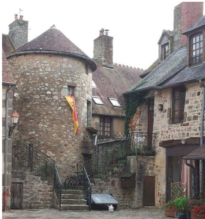
Figure 25) Logement aménagé dans une tour médiévale, place de la roirie, Dormfront, 2014
