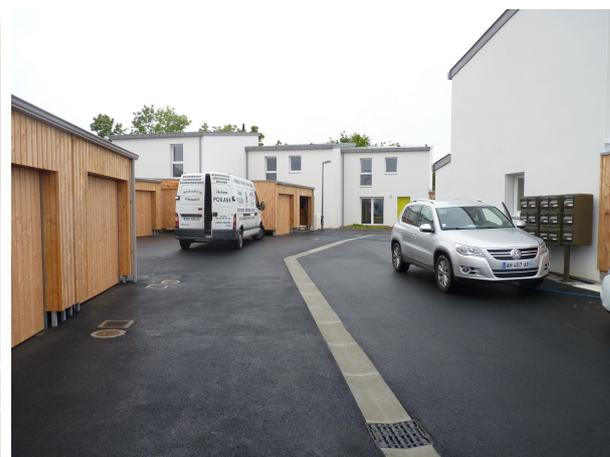
*Figure 16 : Chaussée à structure réservoir – Photographies avant et après mise en oeuvre (source : Céramide, 2013)*
