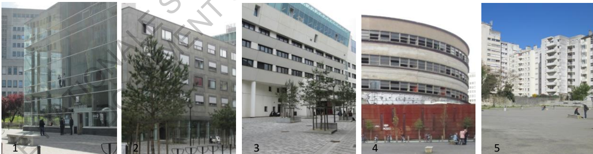
Figure 3 Bâtiments caractéristiques du site. Source : Photos de l'auteur.
