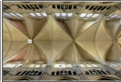
1. La voûte de la nef centrale. La voûte sur croisée d'ogives permet d'alléger le poids des murs et de faire de grandes ouvertures qui font entrer la lumière. 2. Croisée et voûte d'ogives. 3. Vitraux. 4. Croisée. 5. Nef centrale.
