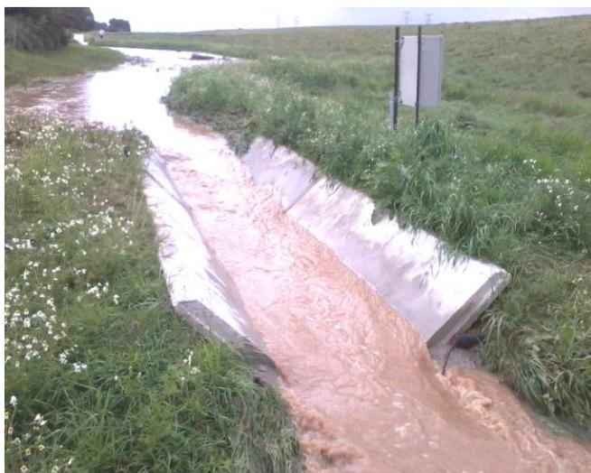
La station de mesure de FDCM est mise en place en avril 2012, la mesure des débits se font instantanément par couplage d'un capteur hauteur-vitesse au niveau de fossés trapézoïdaux
