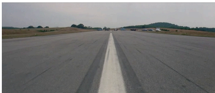
Fig. 68 : Macadam à deux voies , la route envahissante et vaine
