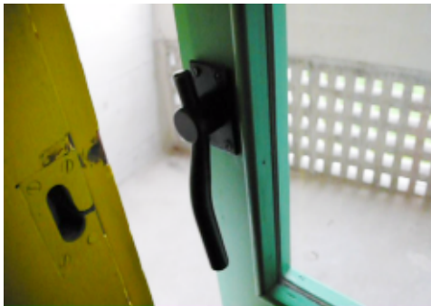
fig. 4 : Poignée de Le Corbusier au Couvert de la Tourette. Cette poignée ferme la porte grâce à son propre poids, dont on devient sensible lors de l'usage.
