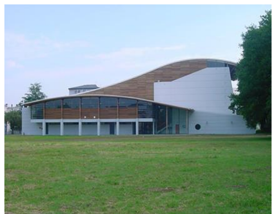
Photo 9: Halle des Sports de Pau
