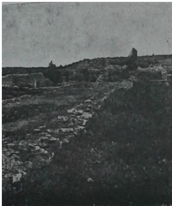
Mur bahut de la grande cour
