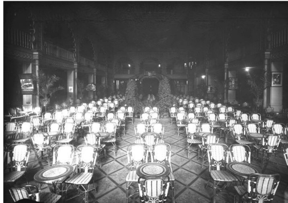
Figure 10 : Hall des Folies-Bergère, 1925 (photographie des Folies-Bergère).
