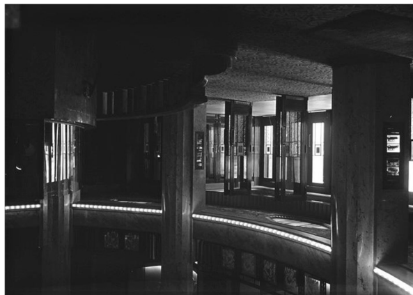
Figure 6 : Entrée des Folies-Bergère, 1928 (photographie des frères Séeberger).
