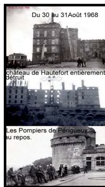
Visuel 03 : Photos de l'incendie qui ravagea le château en 1968.
