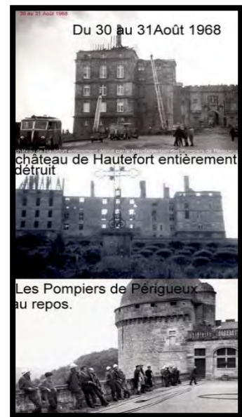
Visuel 03 : Photos de l'incendie qui ravagea le château en 1968.
